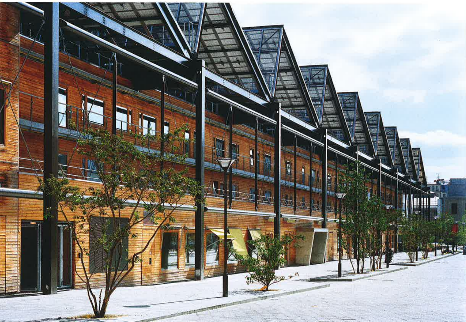
▲ Vue depuis l'Esplanade Nathalie Sarraute. 3 500 m 2 de panneaux photovoltaïques, disposés sur les sheds, permettent au bâtiment d'avoir un bilan énergétique positif.
